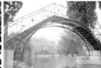
Puente de hierro
